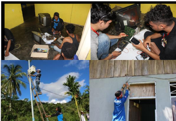
Gambar 3 Perbaikan dan Instalasi
