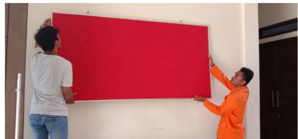
Gambar 4 Pembuatan dan Pemasangan Papan Pengumuman
