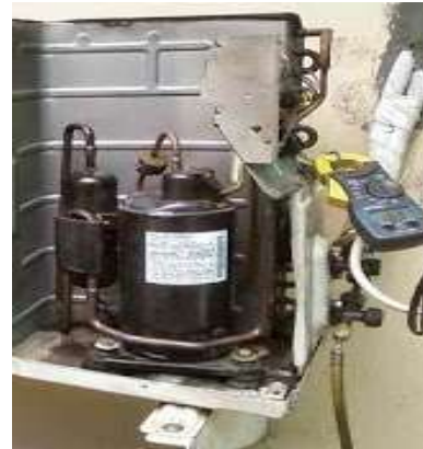
Gambar 4. Kompresor AC
